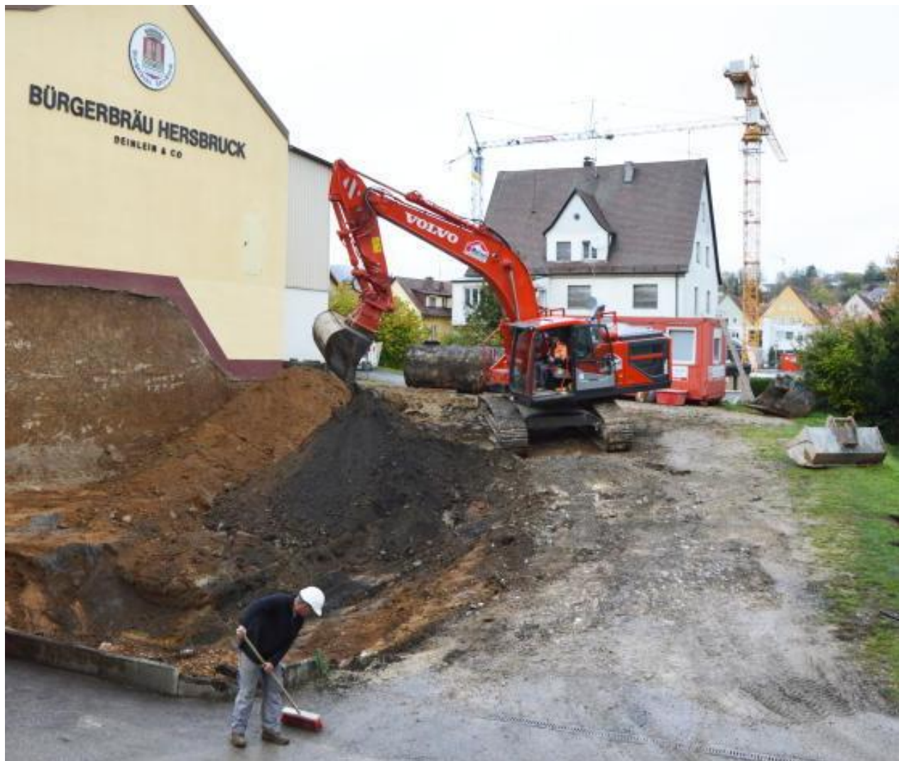
Die Vorarbeiten für die Heizzentrale laufen. Im späten Frühjahr soll sie laufen und unter anderem auch den ersten Wohnblock auf dem Schickedanz-Areal (Kräne im Hintergrund auf der Baustelle) mit versorgen. Foto: M. Scholz
